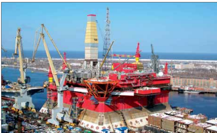
СТРОИТЕЛЬСТВО БУРОВОЙ ПЛАТФОРМЫ «ПРИРАЗЛОМНАЯ» НА ПО «СЕВМАШ»
