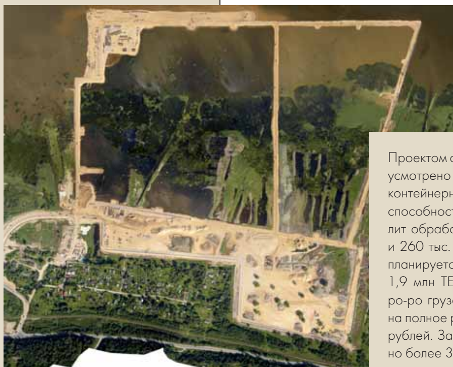
Аэрофотосъемка территории ММПК «Бронка» по состоянию на июль 2011 г.
