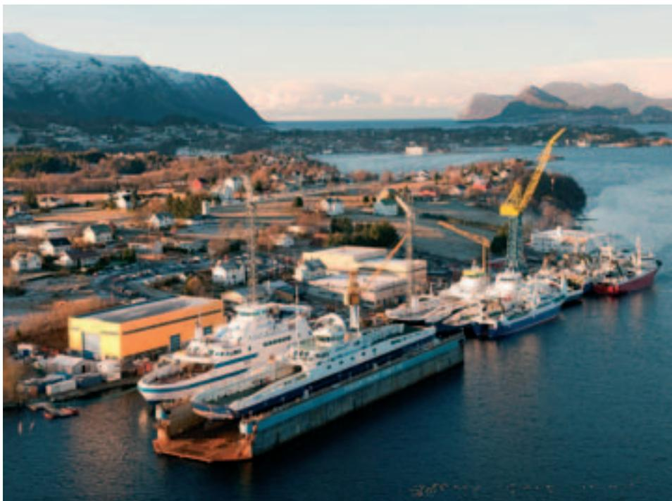
В настоящее время на верфи строятся два судна обслуживания рыболовных ферм по проекту компании Multi Maritime на класс DNV, которые планируется сдать заказчику в 2-3 квартале 2014 года. Суда имеют длину 69,9 м, ширину 17,2 м и грузоподъемность 5000 м<sup>3</sup>. Используются газовые двигатели Rolls-Royce.
