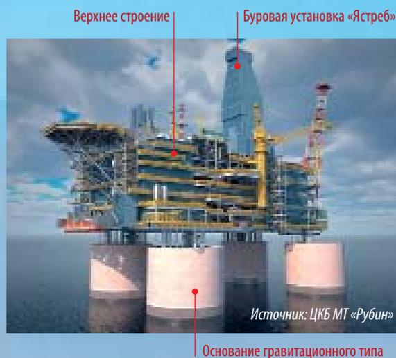
*Учитывая 97 км трубной обвязки и 1900 км кабелей, вес верхнего строения составляет около 42 тыс. тонн. Вместе с бетонным основанием вес этой гигантской конструкции вырастает до 200 тыс. тонн.*
