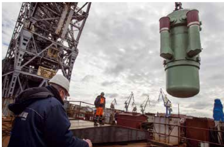
Корпус реактора интегрального типа РУ РИТМ-200
