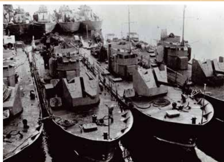
Подготовка на Балтийском заводе броневых морских охотников к ходовым и сдаточным испытаниям
