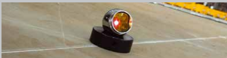
Измерение величины сварочных деформаций полотниц обшивки при помощи лазерного трекера
