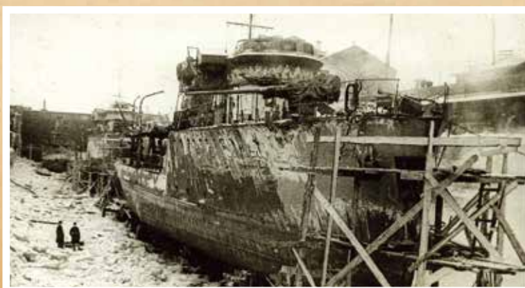
Зимний ремонт в доке Морзавода
