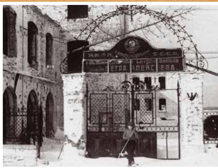
Разрушенная проходная ситценабивной фабрики им. Петра Алексеева, которая стала частью восстановленного Невского судостроительно-судоремонтного завода
