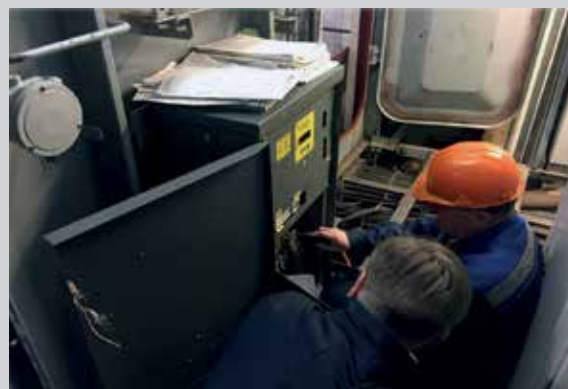
Установка ИПКЗ на судне
