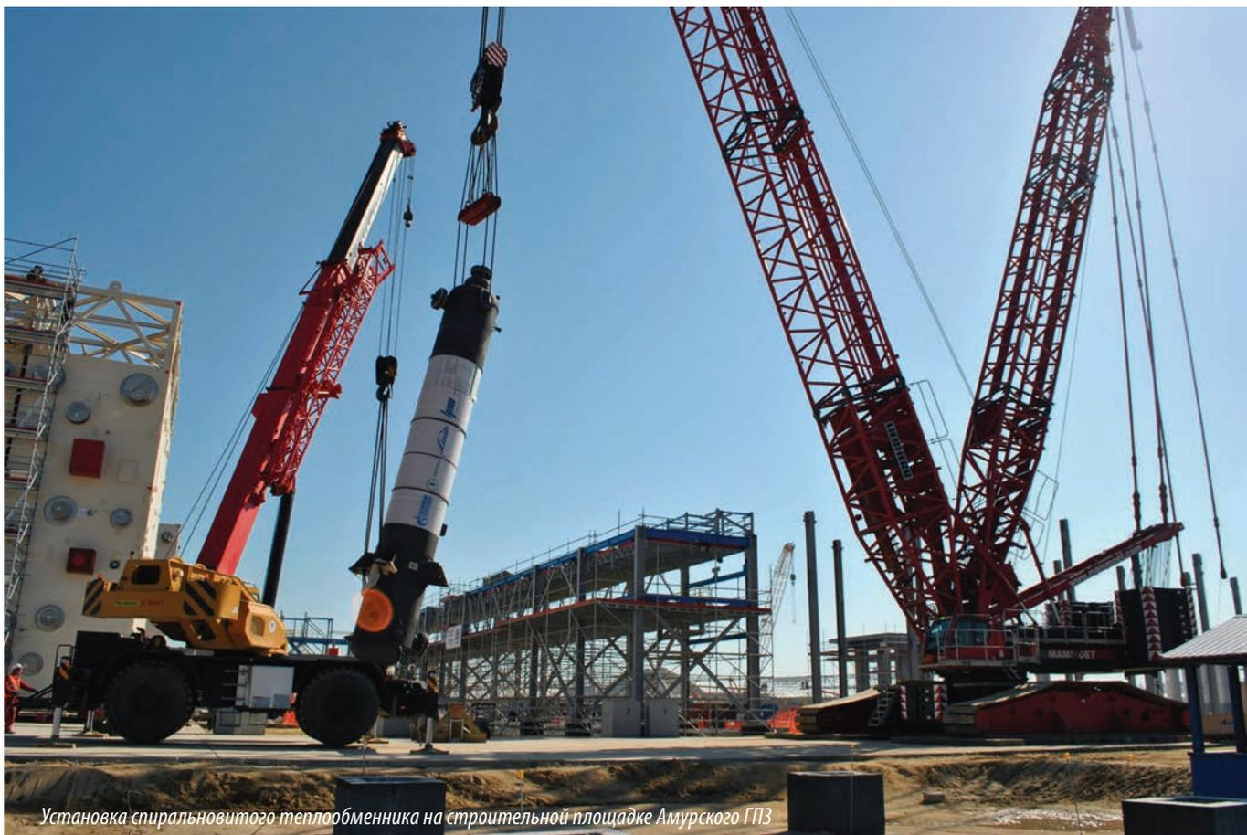
Установка спиральновитого теплообменника на строительной площадке Амурского ГПЗ
