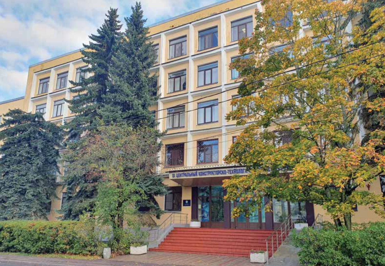
Центральное здание 51 ЦКТИС в г. Ломоносов
